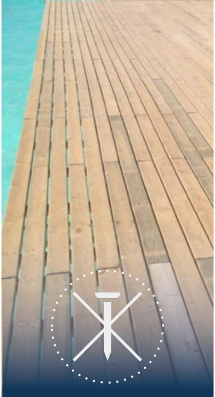
**Sin clavos.** La madera es instalada con tornillos de alta gama.
